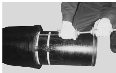
写真-25 打ち込みハンマー使用
