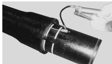
写真-24 滑剤注入器を使用
